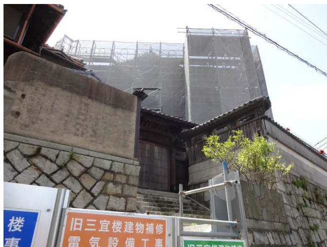
改修工事中の三宣楼
