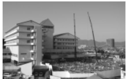
建設が進む緩和ケア病棟
