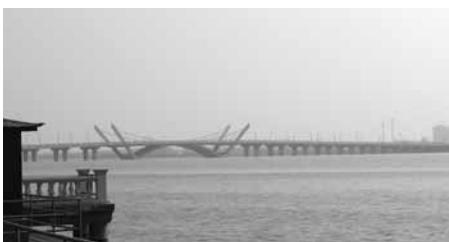
市街地と太湖沿岸部の開発区をつなぐ梨湖大橋(無錫市濱湖区)
