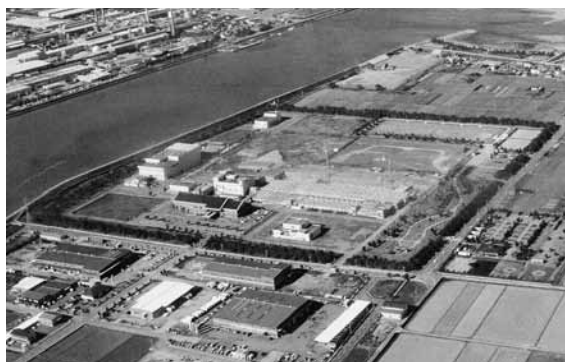
松阪浄化センター（高須町）
