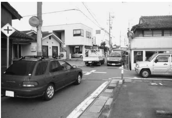
高町松江岩内線の拡幅工事未着手路線（茶与町）
