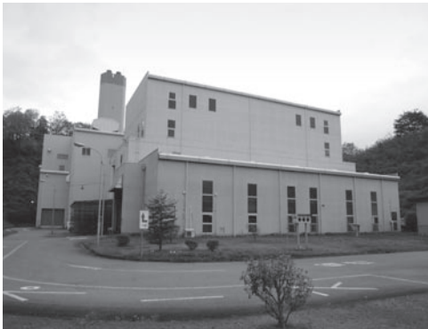
第二清掃工場(桂瀬町)
