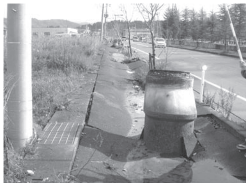
新潟県中越地震の液状化により浮き上がったマンホール
