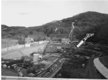
建設中のごみ焼却施設
