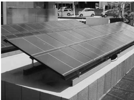
住宅用太陽光発電(ソーラーパネル)
