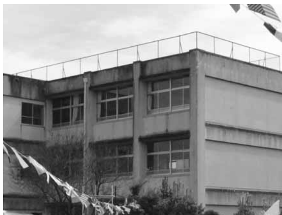
校舎の屋上フェンス
