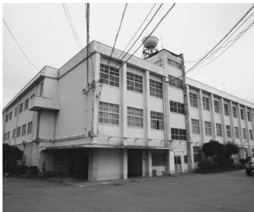
新築から53年以上経過している鎌田中学校
