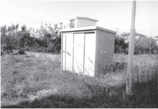
放置された状態の自主防災会資機材倉庫
