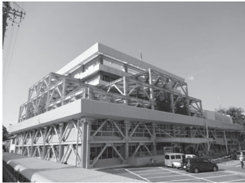
問い合わせの多い市役所補強工事
