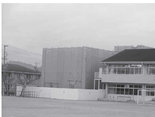
増設工事中の天白小学校
