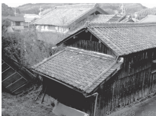
急がれる空き家対策
