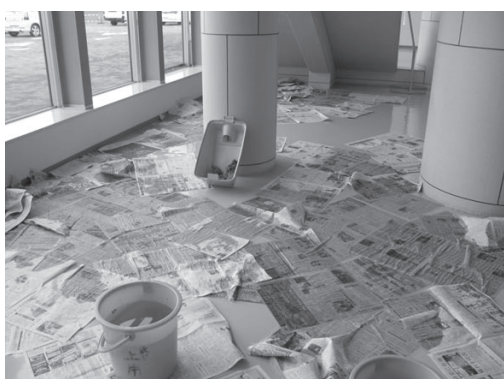
台風4号により浸水したハートフルみくも文化センター
