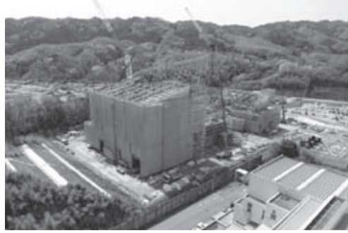
松阪市クリーンセンター（建設中）
