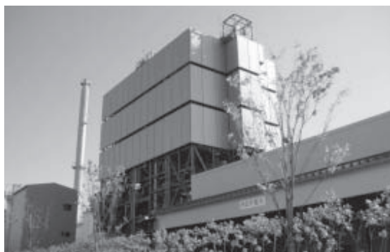
三重ごみ固形燃料発電所
