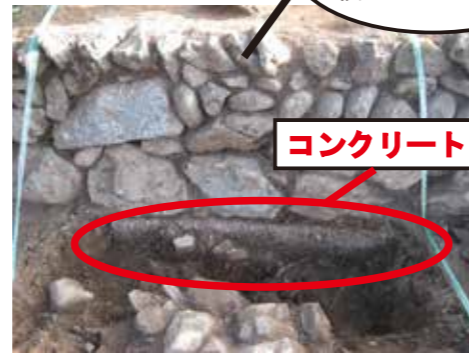
石垣の下にコンクリートを発見！【写真①】
