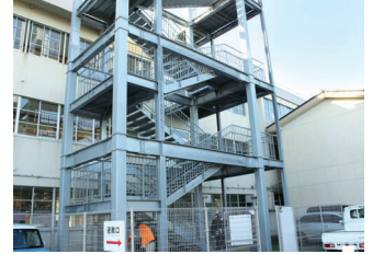
校舎外階段の設置
