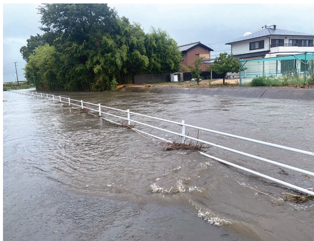
市道松ヶ島長泉寺線 (百々川堤防長泉寺)
