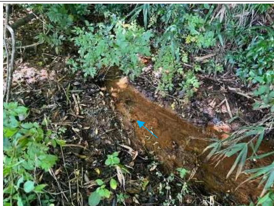
土砂の堆積状況
