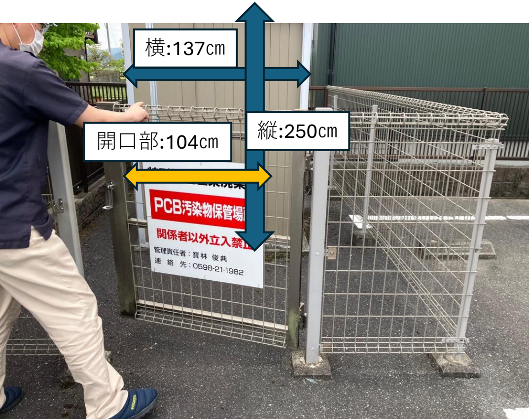
写真5.保管庫及び間口寸法
