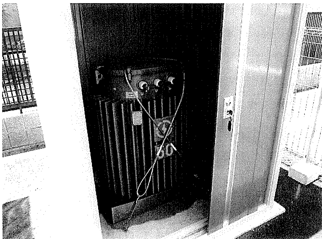
PCB保管状況写真②
