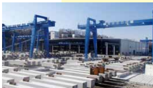
播磨工場（建築工所用 Pca 工場）
