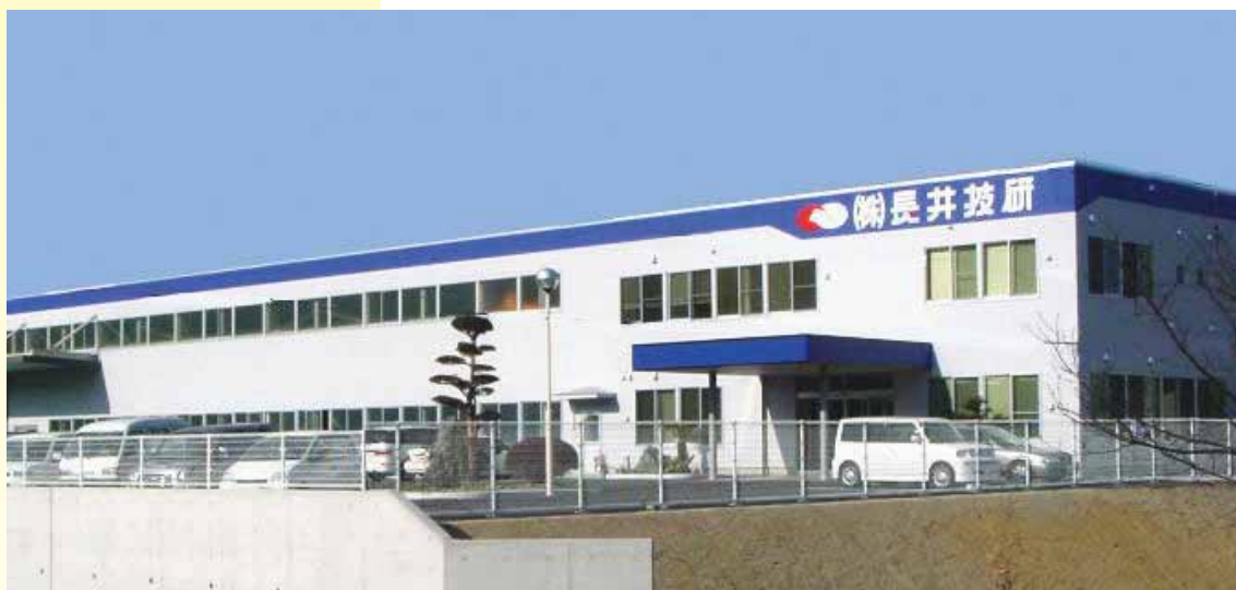
本社工場建物
