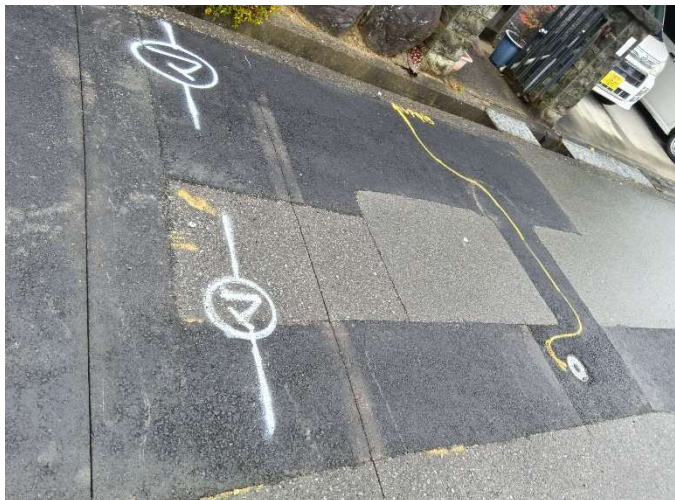
写真-3 現場施工状況
