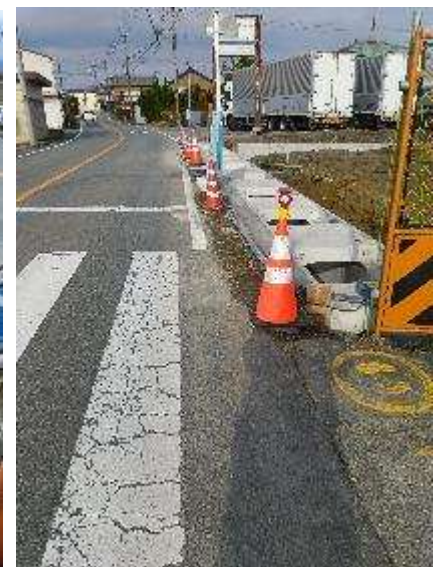
写真-7 現場施工状況
