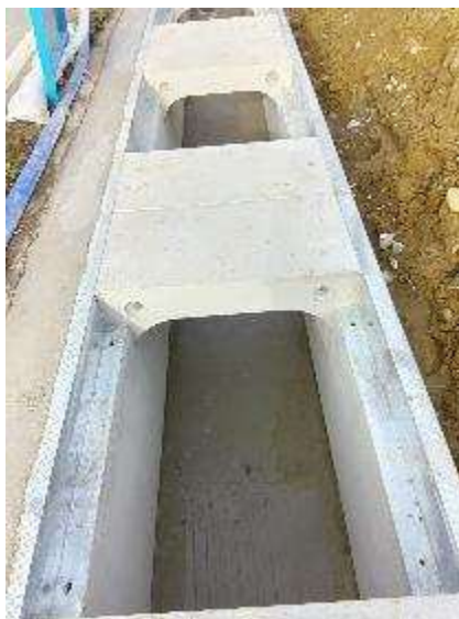
写真-5 現場施工状況
