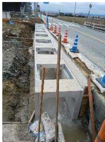
写真-6 現場施工状況
