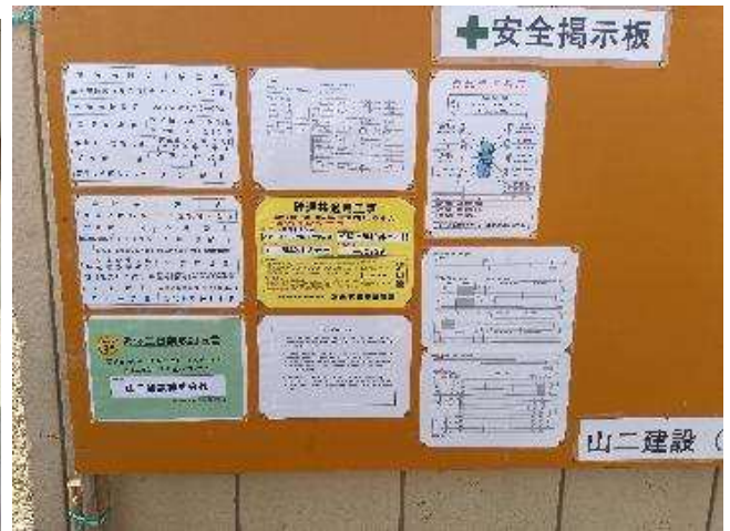
写真-2 工事看板設置状況
