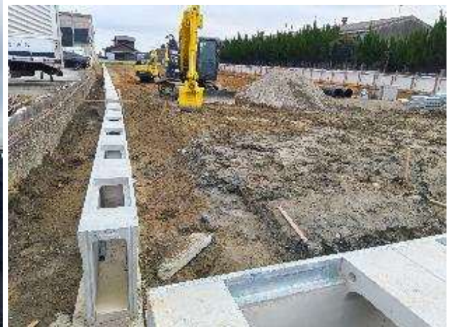
写真-4 現場施工状況
