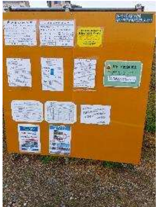
写真-2 工事看板設置状況
