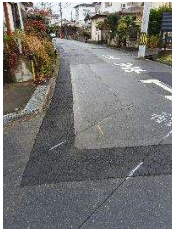
写真-4 現場施工状況
