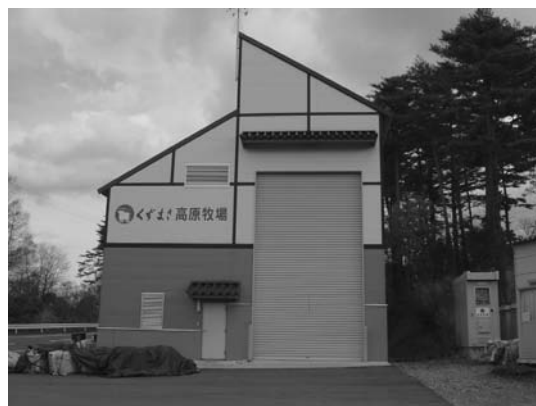
木質バイオマスガス化発電施設
