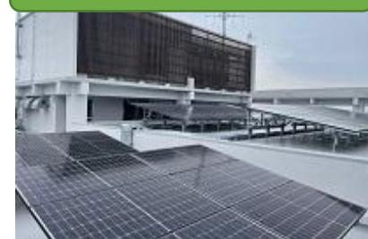
再生可能エネルギーの利用促進の取組として、市役所本庁舎の屋上に太陽光パネル132枚と、屋内に4基の蓄電池を設置しました。太陽光発電により光熱費を削減し、地球温暖化の原因となる温室効果ガス排出を抑制します。災害による停電時には、蓄電池に蓄えている電力を供給することで、業務継続計画に基づく各部門の活動拠点施設としての機能を確保します。
