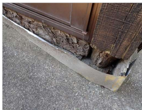
若葉一般住宅の土台部の進行した腐朽
