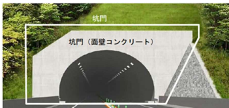
別図-1.2 点検対象箇所（トンネル坑口部）
