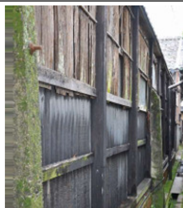
建造物 大正座敷北側塀
