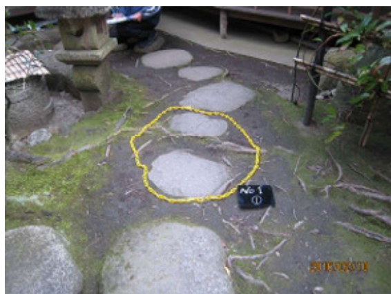
石組 アカマツ樹根による不陸
