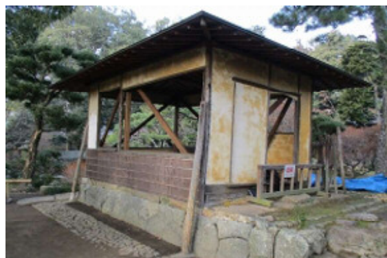
建造物 四阿の応急修理
