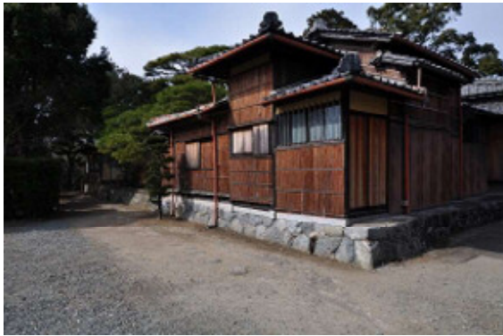
g-1 離れ茶室棟南(東から)
