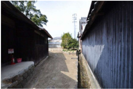
h-1 離れ座敷棟東(南から)
