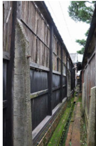
d-4 庭塀と北塀の間(西から)
