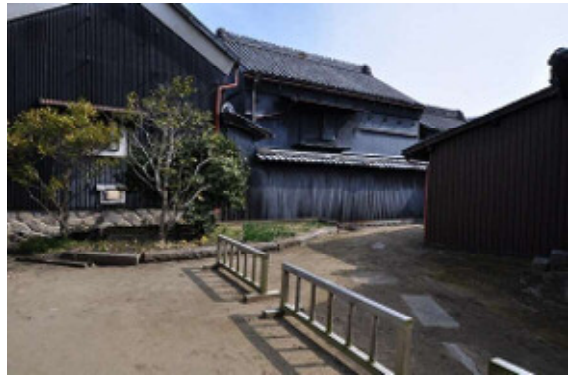
h-2 離れ座敷棟北(西から)
