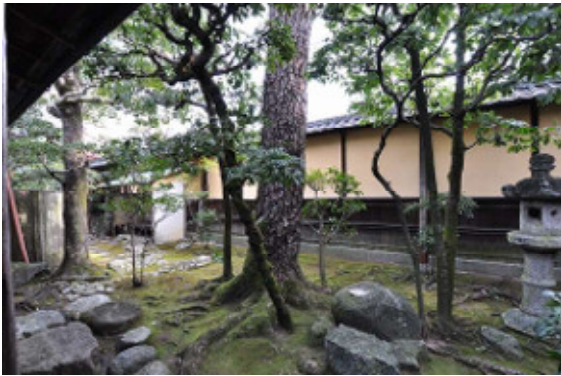
a-1 主屋主体部東(南から)
