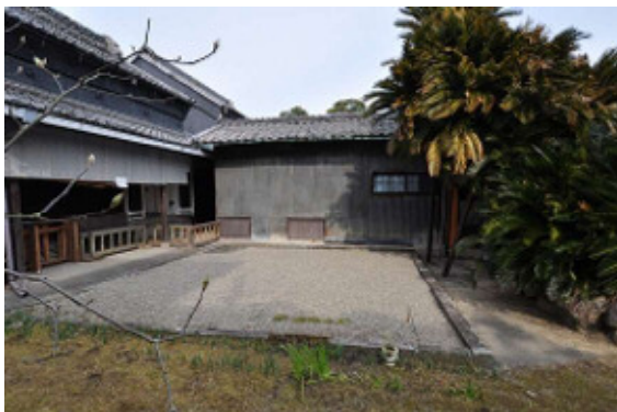
f-3 米蔵東(南から)
