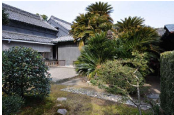
e-2 主屋新座敷部南(東から)
