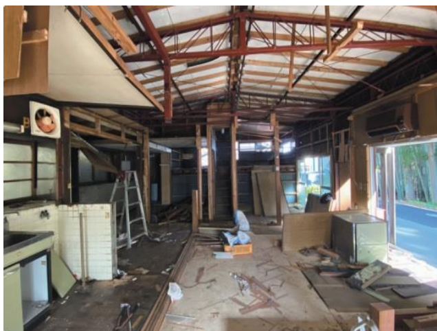
<改装中の古民家>
