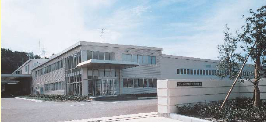
松阪工場外観
