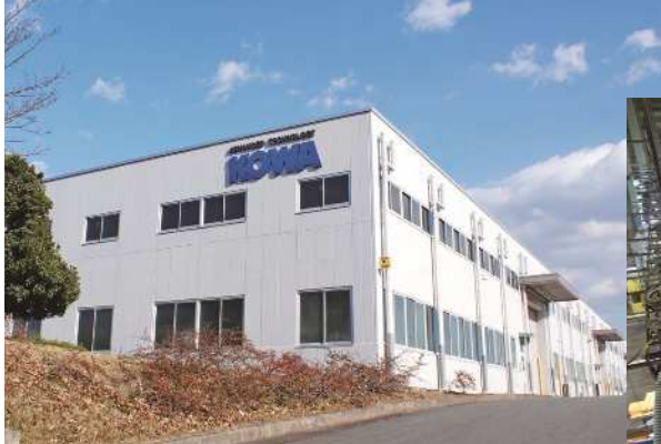
松阪工場外観
