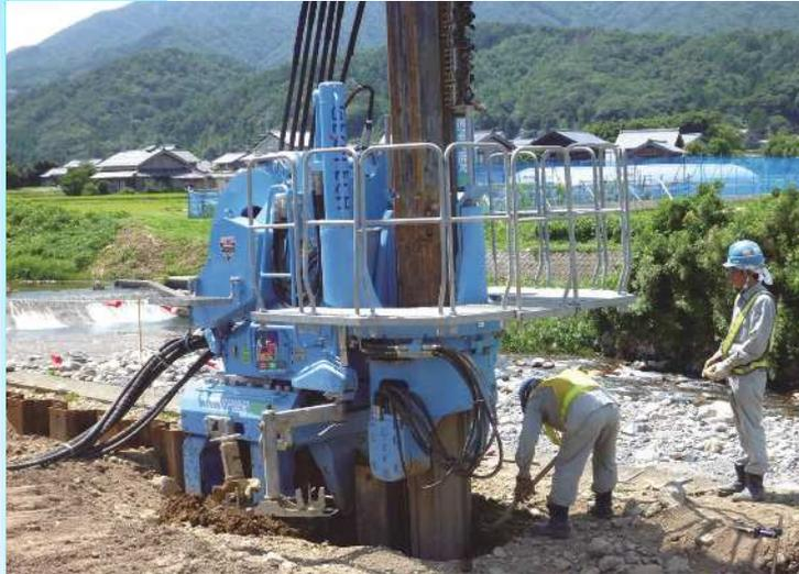
サイレントパイラーによる鋼矢板工事の様子
