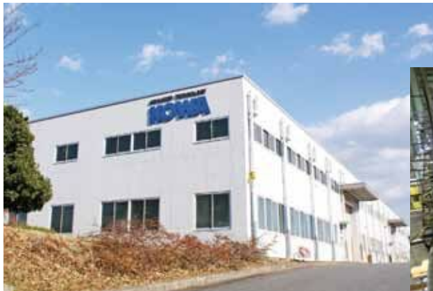
松阪工場外観
