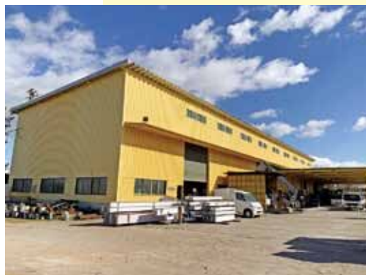
塗装・溶射工場
