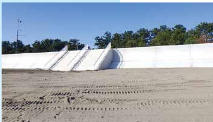
大淀漁港海岸高潮対策事業堤防改良工事
