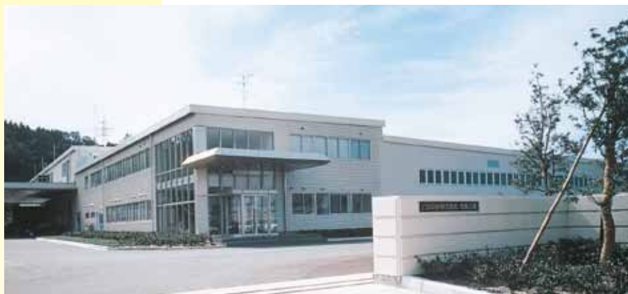
松阪工場外観
