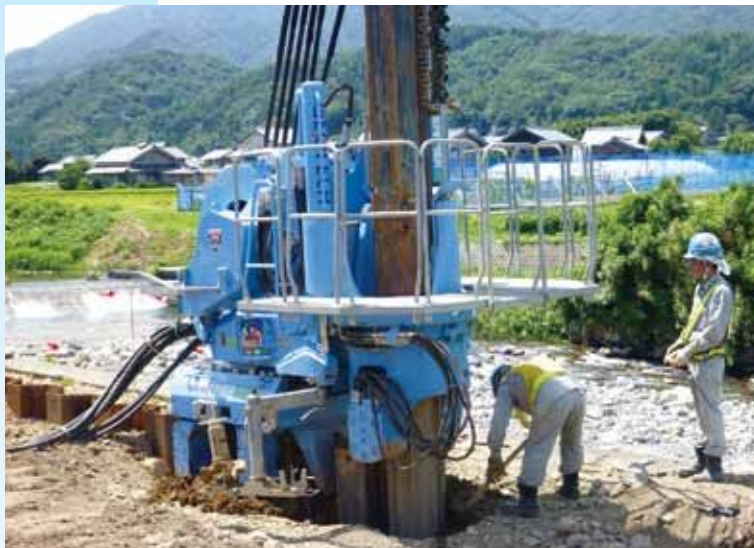
サイレントパイラーによる鋼矢板工事の様子
