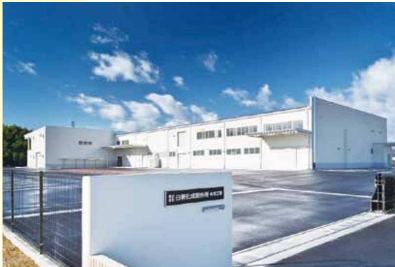
(株)日新化成製作所 多気工場
