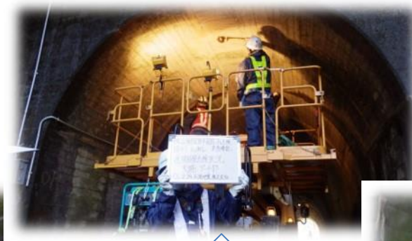
打音検査の状況
