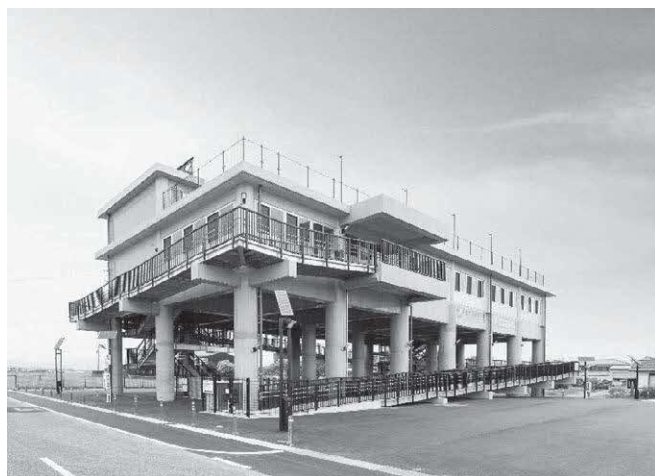
五主津波避難タワー建設 (五主町)
