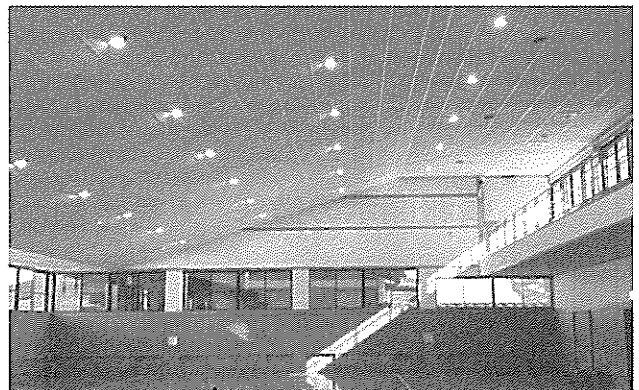
阪内川スポーツ公園施設整備 (大足町)
