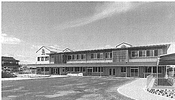
わかすぎ第三保育園園舎新築【建設補助】 (甚目町)
