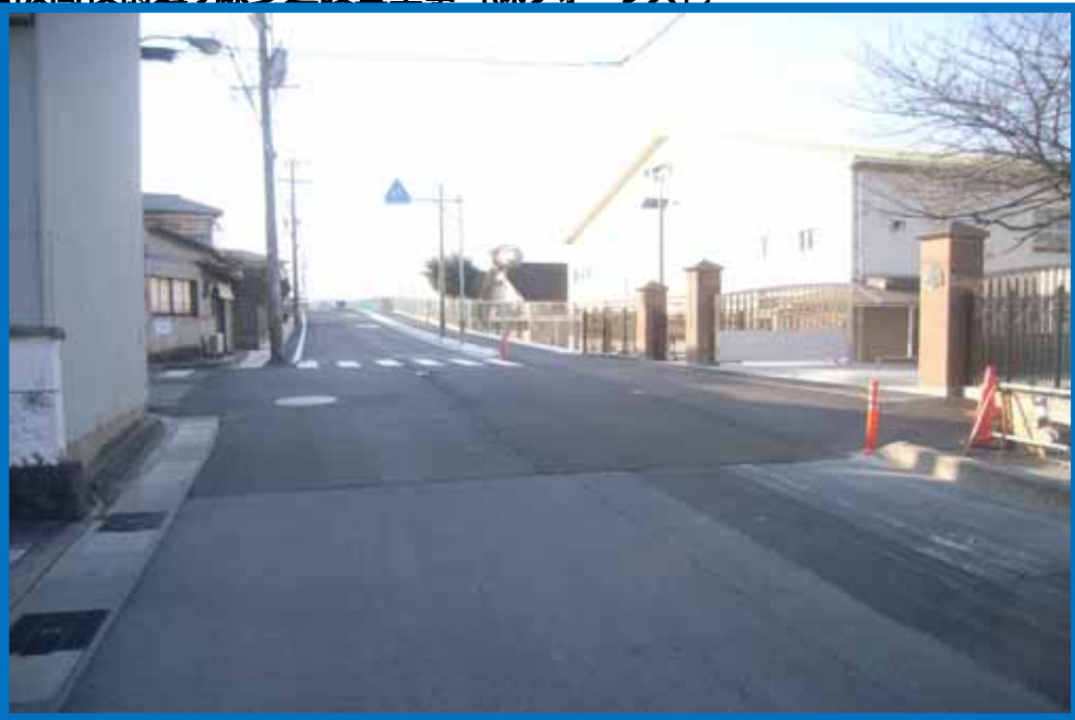
松阪高校前通り線歩道設置工事 (株フォーレスト)
