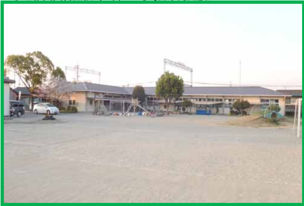
てい水幼稚園園舎屋根葺き替え工事 (株)中勢建設
