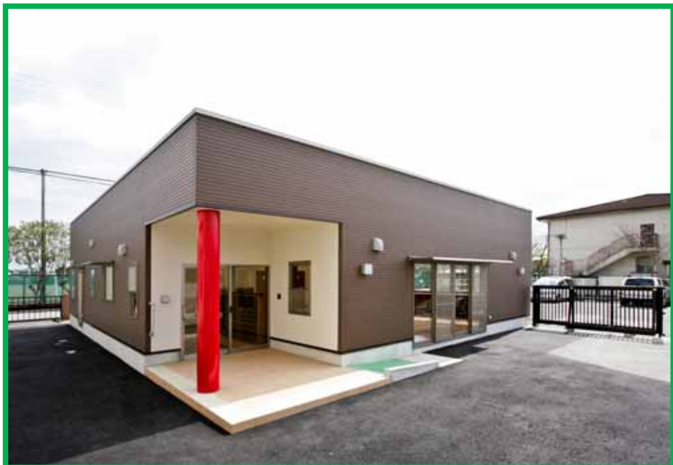
幸小学校区放課後児童クラブ 専用施設新築工事「(有)伊藤工務店」
