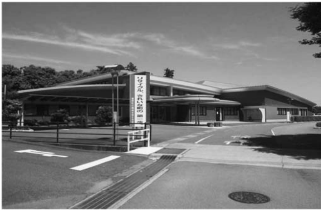
嬉野地域振興局局舎移転整備 (嬉野町)
