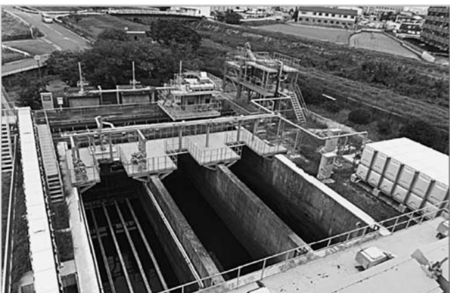
都市下水路施設 宮町ポンプ場施設長寿命化 (東町)
