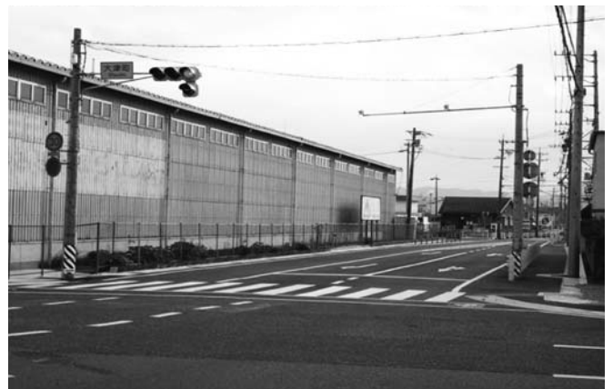
道路整備 海会寺幸生線 (大津町)
