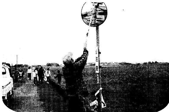
カーブミラーの清掃作業
