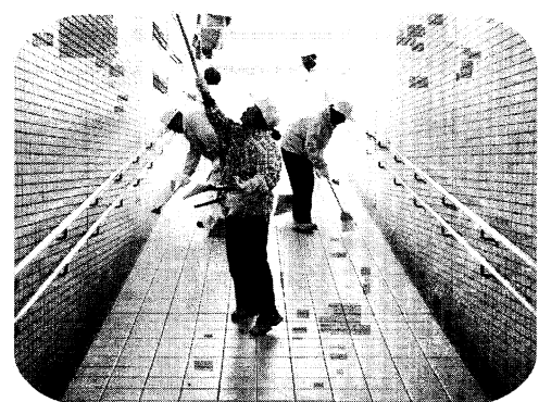
中川駅地下道の清掃作業
