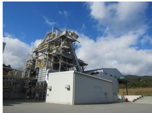
■木質バイオマス発電所
