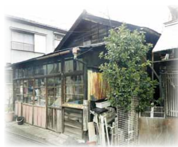
▲倒壊や衛生上問題のある不良空き家
