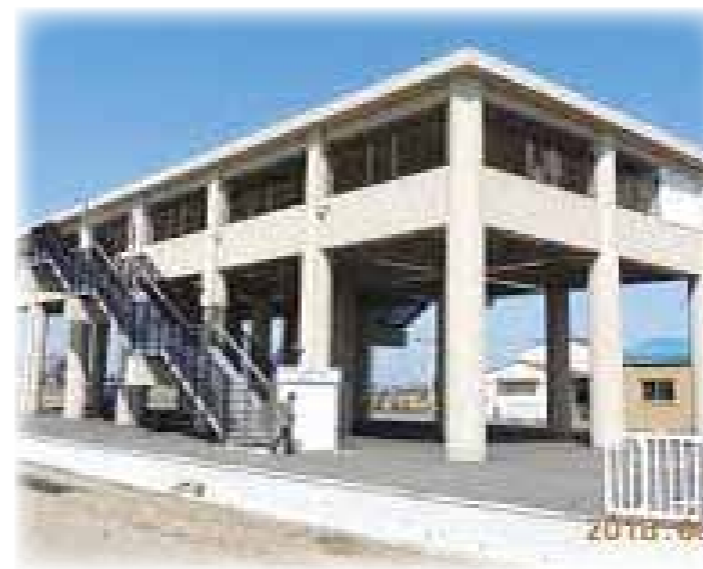
▲津波避難タワー（明和町）
