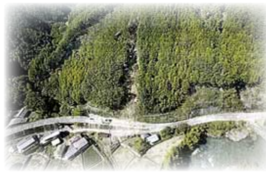
▲国道166号 山腹崩壊の現場
