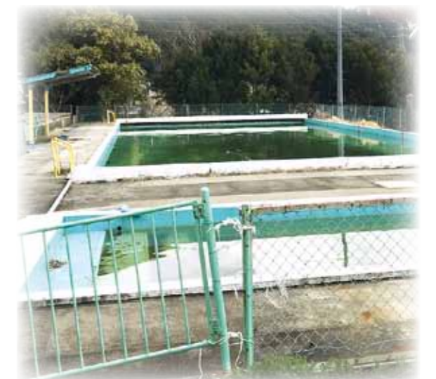
▲粥見小学校プール
