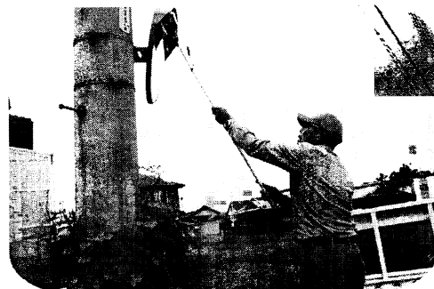
カーブミラーの清掃作業
