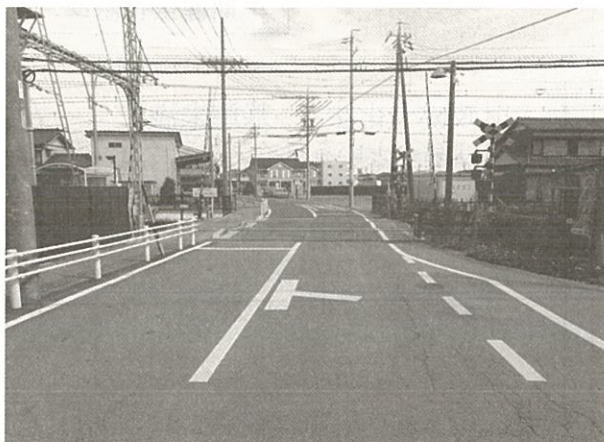
海会寺幸生線歩道設置 (大津町)
