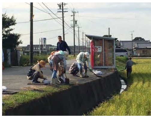
新屋敷町の水路清掃の様子
