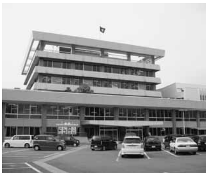
耐震補強が必要な本庁舎
