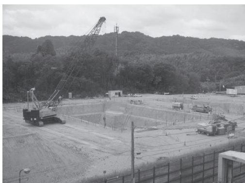
工事が順調に進む新ごみ処理施設
