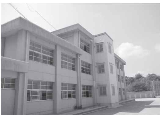
西日が当たり、より暑い中部中学校の新棟
