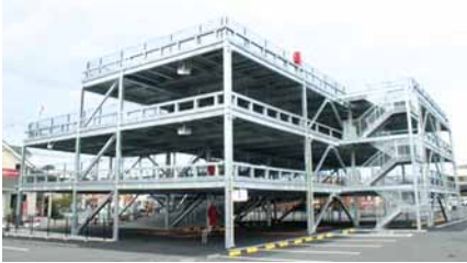
津波避難タワー
