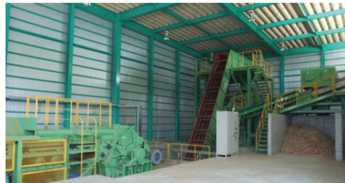
ウッドピア木質バイオマス利用協同組合の破碎施設
