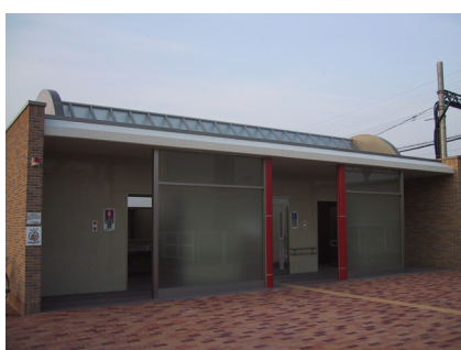
■ 近鉄伊勢中川駅西口広場多機能トイレ
